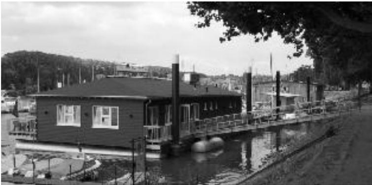
Schwimmendes Restaurant „Arche Noah“ im Schiersteiner Hafen in Wiesbaden. Die Berechnungen und die Konstruktion des kompletten Unterbaus mit den Schwimmern, den Führungen an den Dalben und der Zugangsbrücke wurden von mir erstellt.
